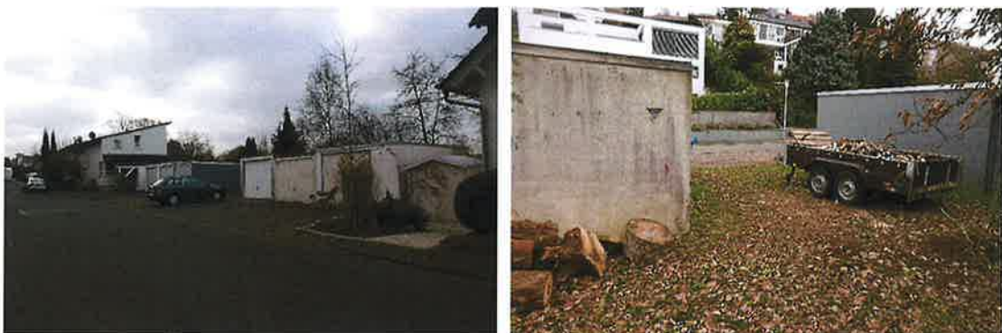
Abbildung 6: Bestehende Bebauung im Plangebiet
