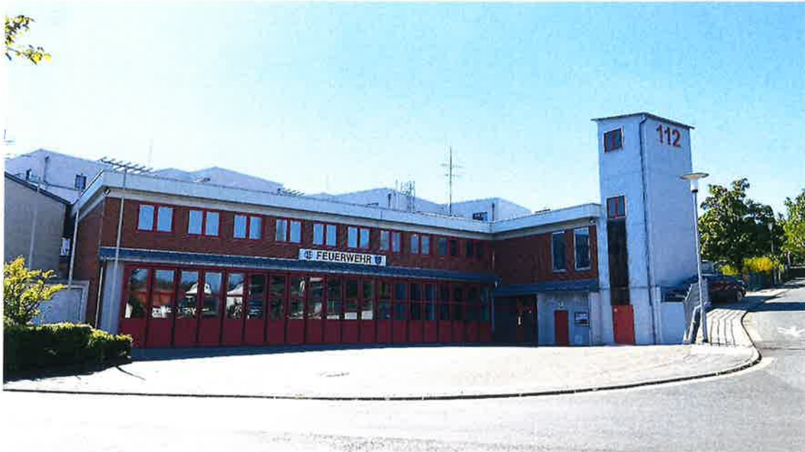
Abbildung 12 - Feuerwehrhaus OT Roßdorf
