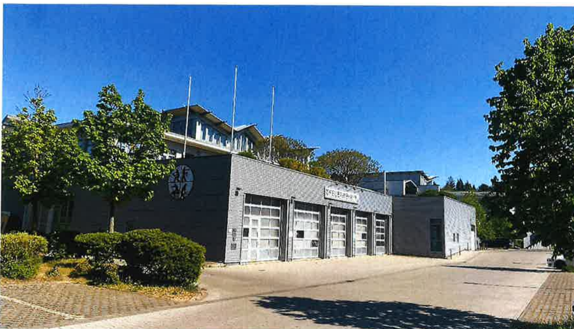
Abbildung 13 - Feuerwehrhaus OT Gundershausen
