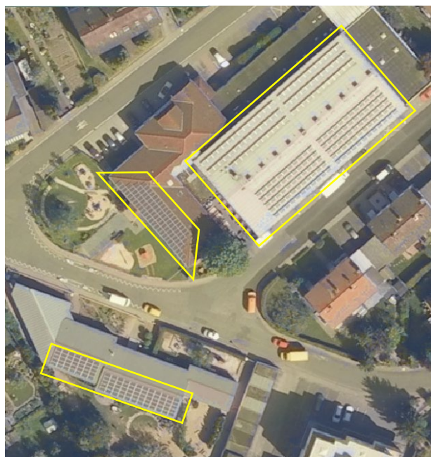
PV-Anlagen Bürgerhaushalle Gundershausen und Kindergarten
